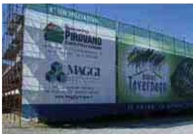
Un'immagine del cantiere
