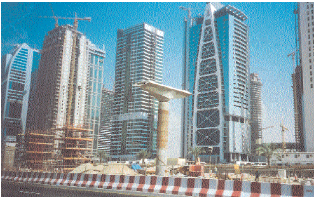
I lavori della metropolitana modificano il "paesaggio"
