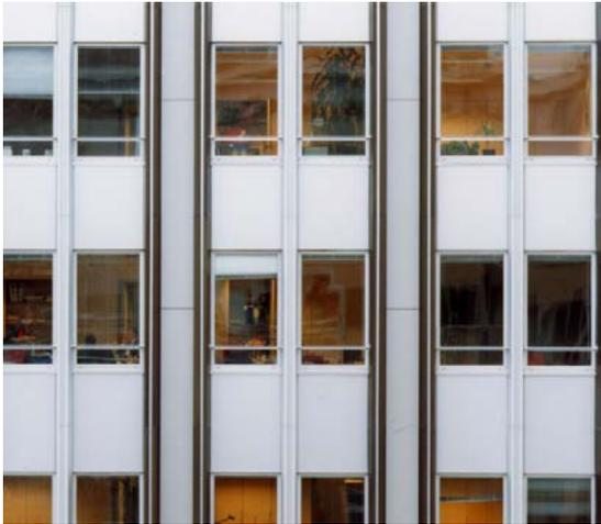
Figura 8 - Facciata rivestita da pannelli in Alucobond
